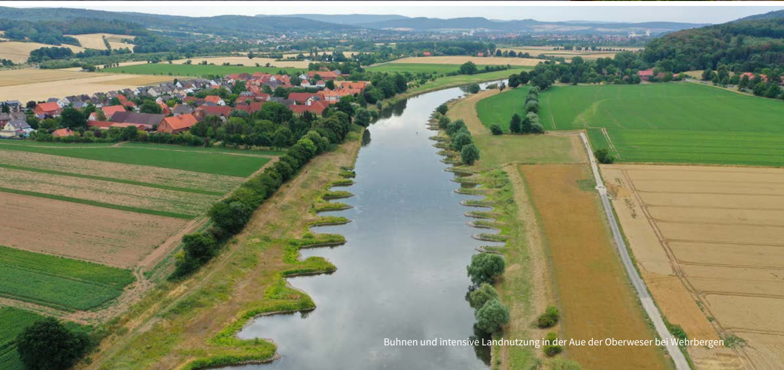
Oberes Wehr Hameln und Schleuse Hameln
