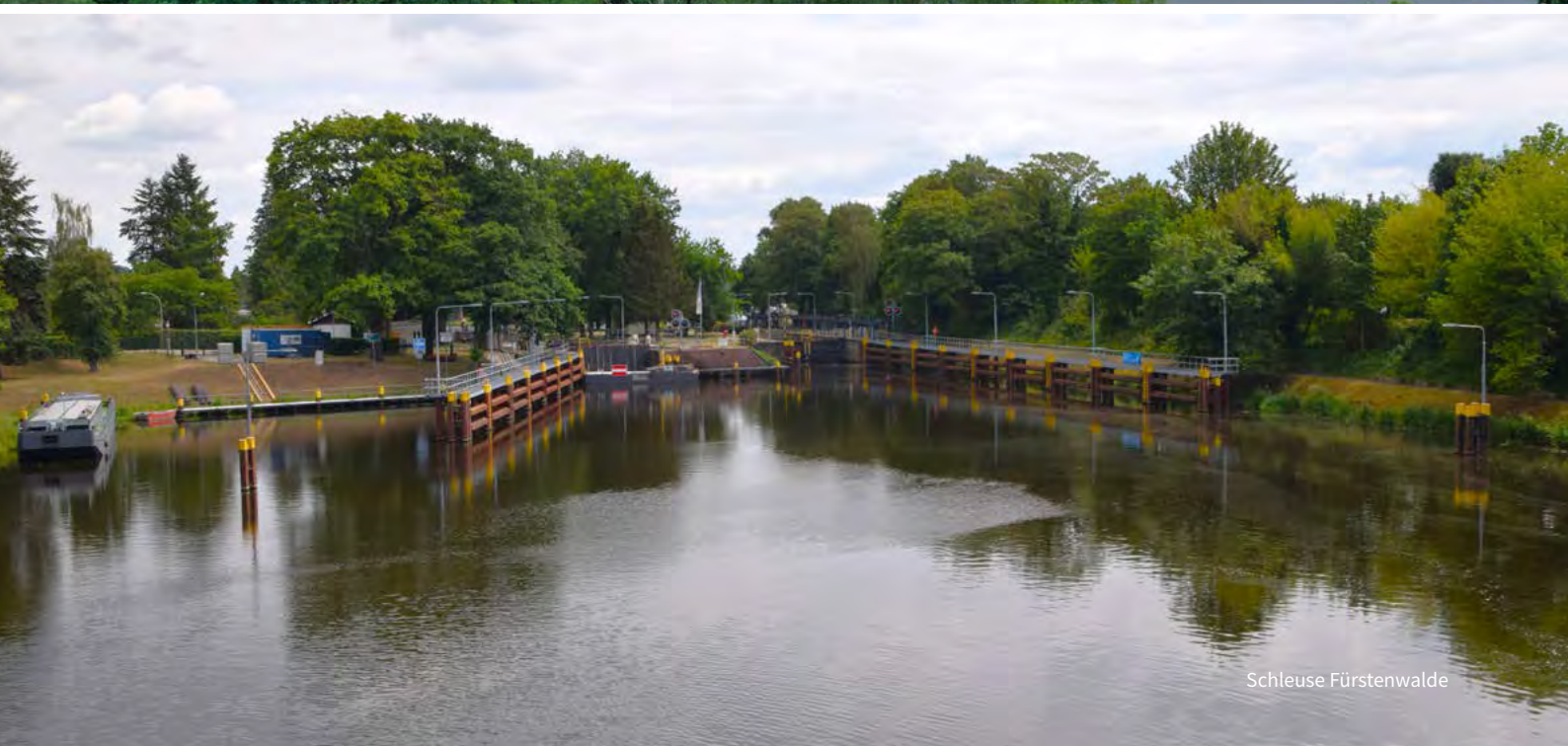
Das Wehr Große Tränke im Abzweig zur Müggelspree
